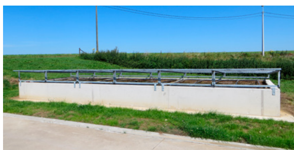
Lit biologique (auto-construction)
