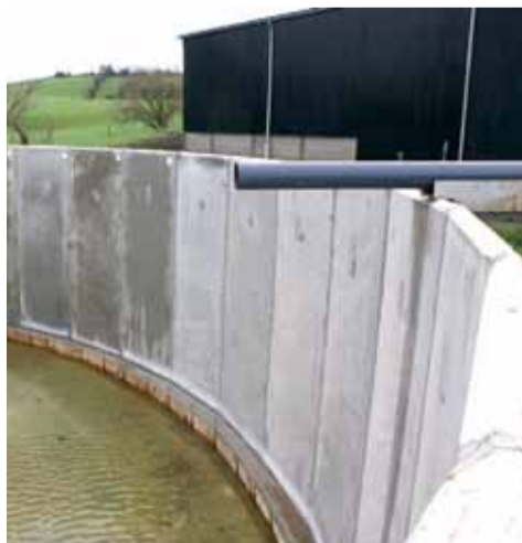
Pour les effluents liquides, la capacité de stockage doit être d'au moins 6 mois
