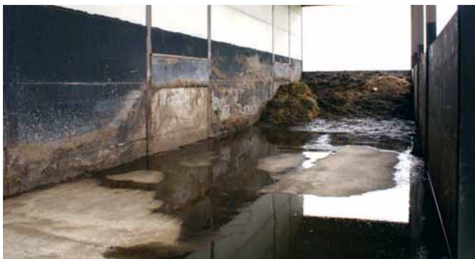
Pour le stockage à la ferme, la fumière doit être bétonnée mais pas forcément couverte, sauf pour des fientes dont la MS est inférieure à 35%
